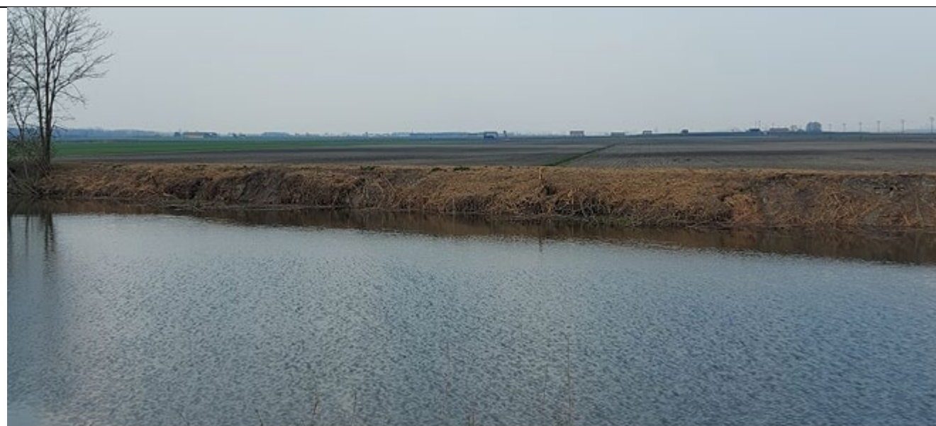
Foto n.1: Foto dissesto idrogeologico – Canale dei Cuori
