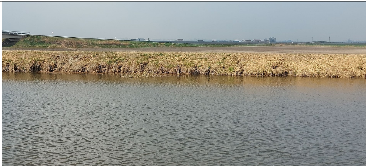
Foto n.2: Foto dissesto idrogeologico – Canale dei Cuori
