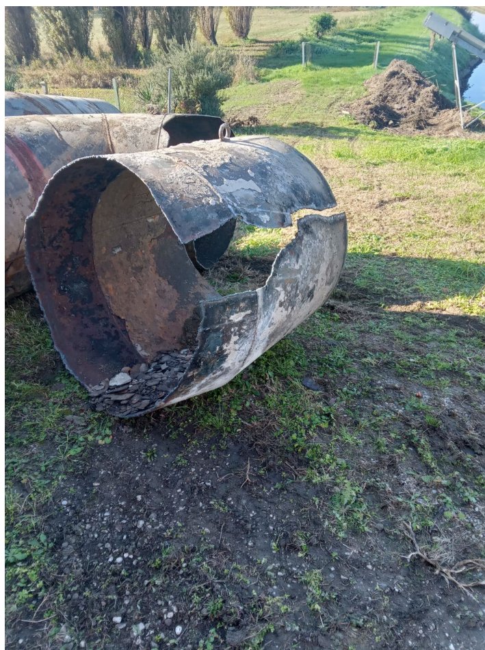
Idrovora Punta Gorzone - rifacimento tratto di condotta di scarico P2 in acciaio zincato.
