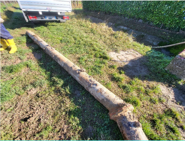
Sifone Giare - rifacimento tratto di condotta in PE.
