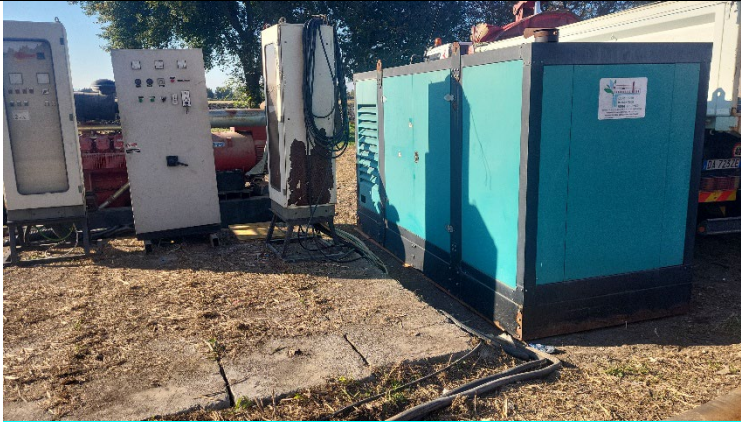
Idrovora Barbegara - installazione pompe di emergenza.
