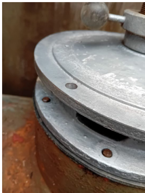
Idrovora Valgrande - revisione valvola di disadescamento.
