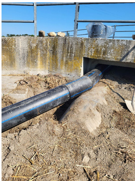
Idrovora Priula - rifacimento tratto di condotta in PE e manutenzione straordinaria P3.
