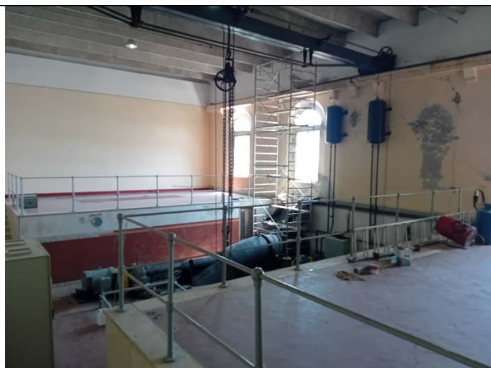
Idrovora Gesia – Risanamento della muratura interna e tinteggiatura – Cavarzere (VE)
