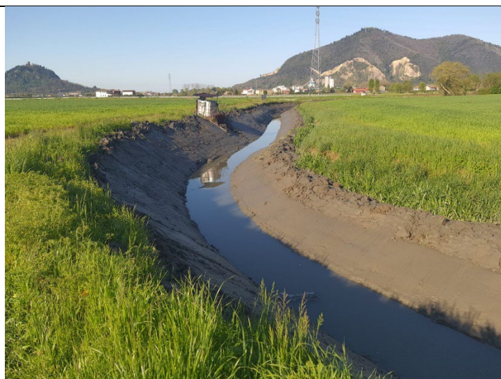
Scolo acque Alte Savellon – Consolidamento spondale con riporto di terreno – Monselice (PD)
