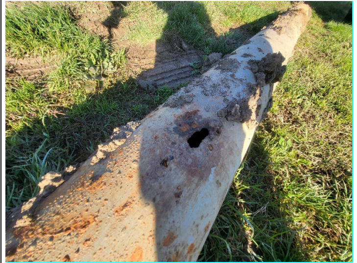
Sifone Giare - rifacimento tratto di condotta in PE.
