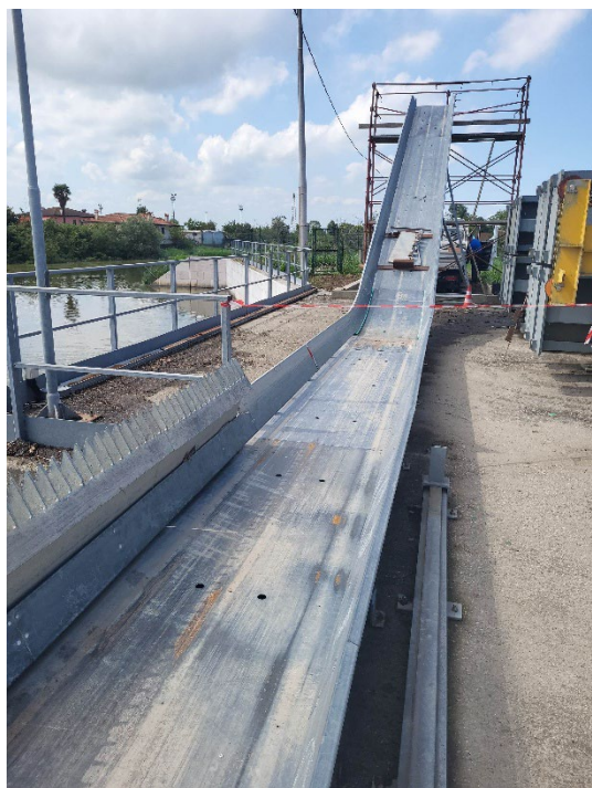
Sostegno Trezze - manutenzione straordinaria nastro sgrigliatore.
