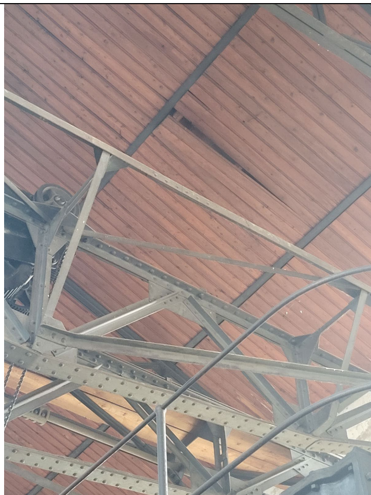
Idrovora Barbegara – Messa in sicurezza del controsoffitto in legno – Correzzola (PD)
