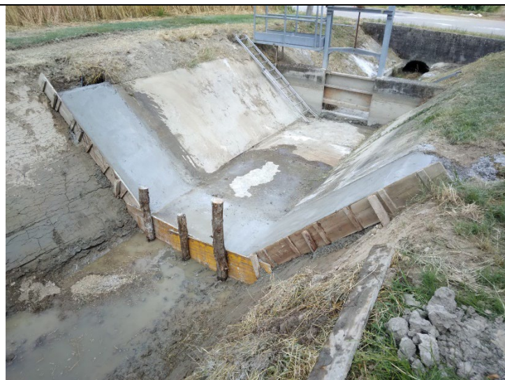
Sostegno Menato – Realizzazione di un nuovo diaframma – San Pietro Viminario (PD)
