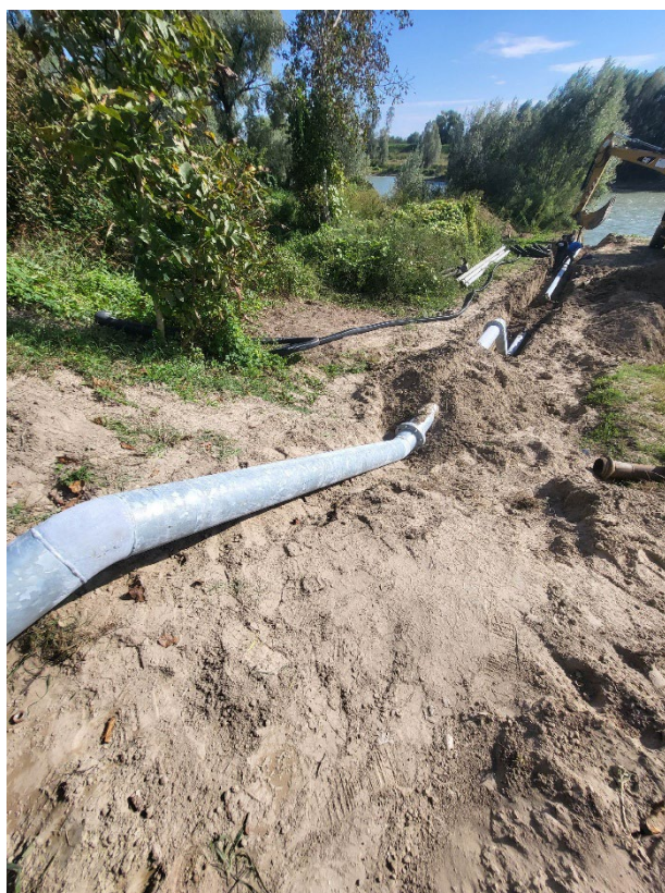
20° Bacino Anguillara Veneta - rifacimento condotta da sommità arginale a punto di presa.
