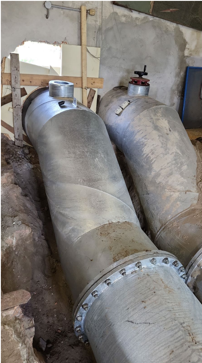
Idrovora Punta Gorzone - rifacimento tratto di condotta di scarico P2 in acciaio zincato.
