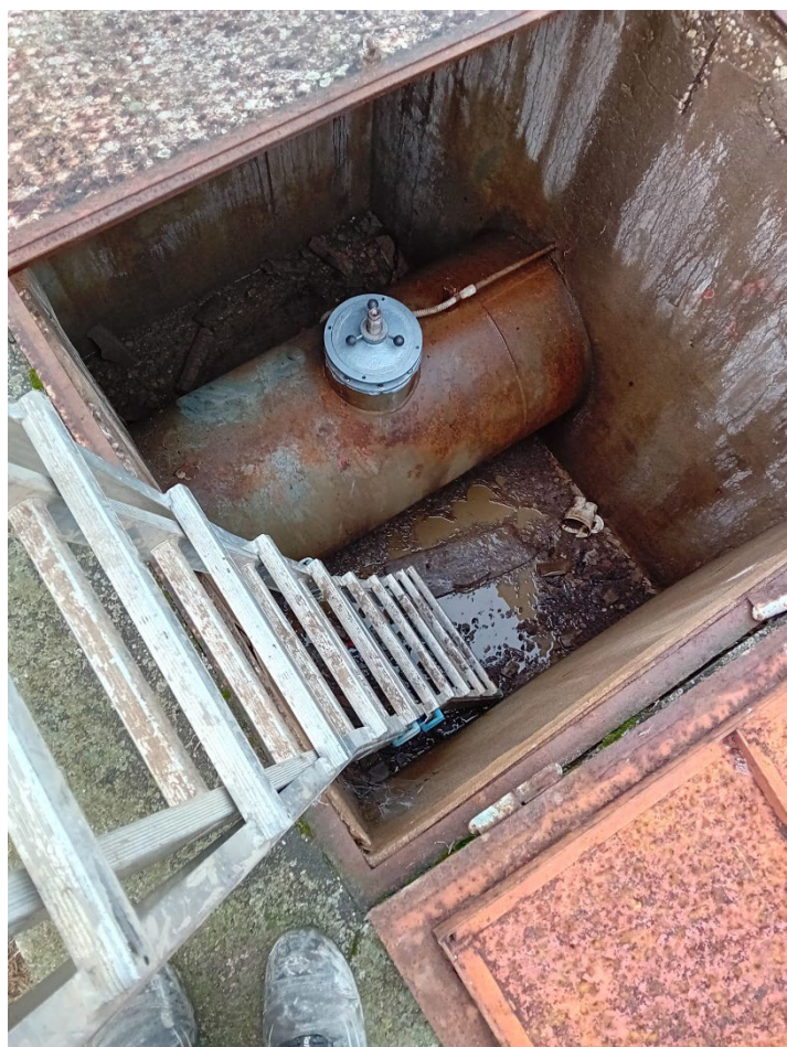
Idrovora Valgrande - revisione valvola di disadescamento.
