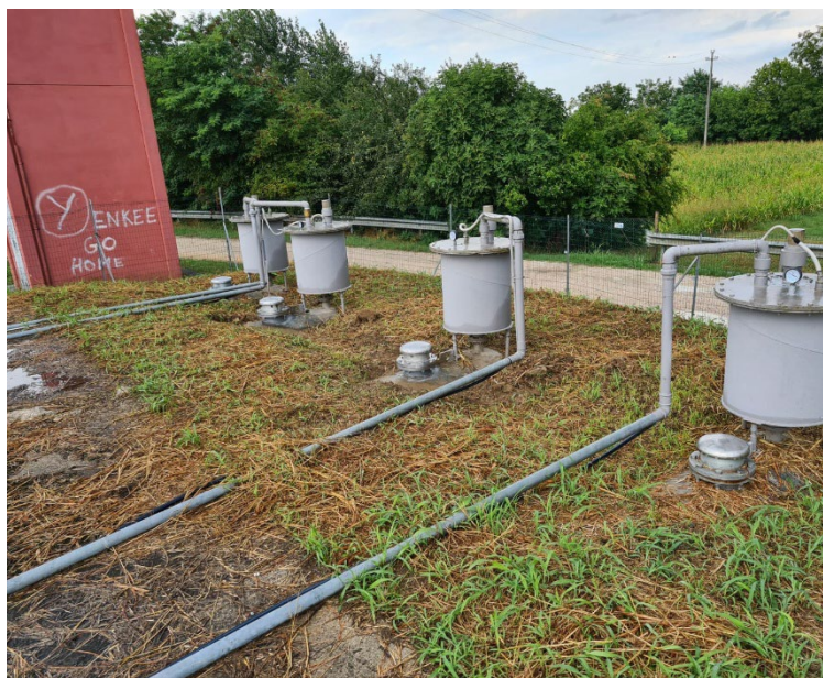
Idrovora Acquanera - installazione valvole di sfiato sulle condotte di scarico pompe verticali.
