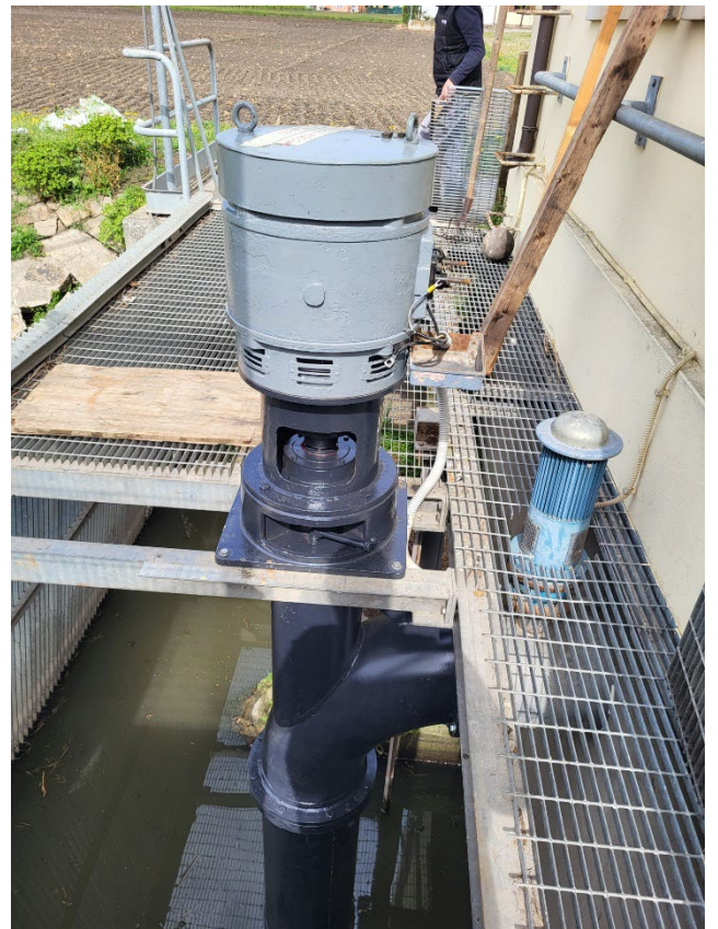
Idrovora Pelosa - lievo e revisione pompa verticale P1.
