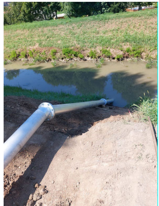
Sifoni Ex Macello - rifacimento tratto di condotta in acciaio zincato.
