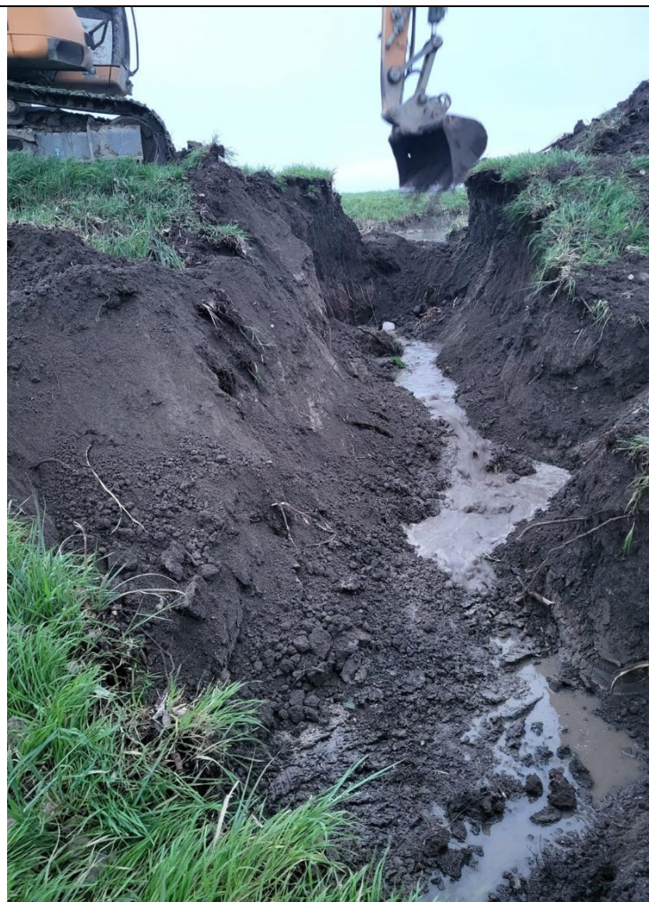
Sistemazione infiltrazione arginali – Canale Altipiano – Bovolenta (PD)
