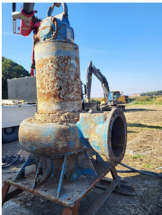
Idrovora Barbegara - installazione pompe di emergenza a seguito somma urgenza.
