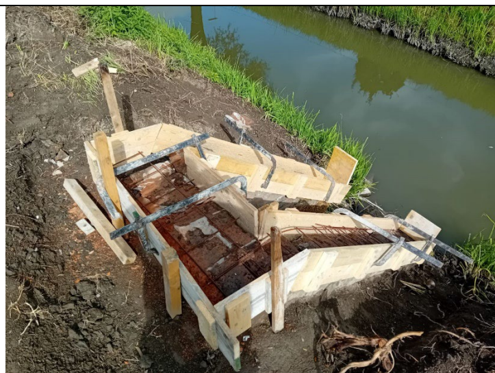
Riparazione opera di presa Sabbadina – Barbona (PD)
