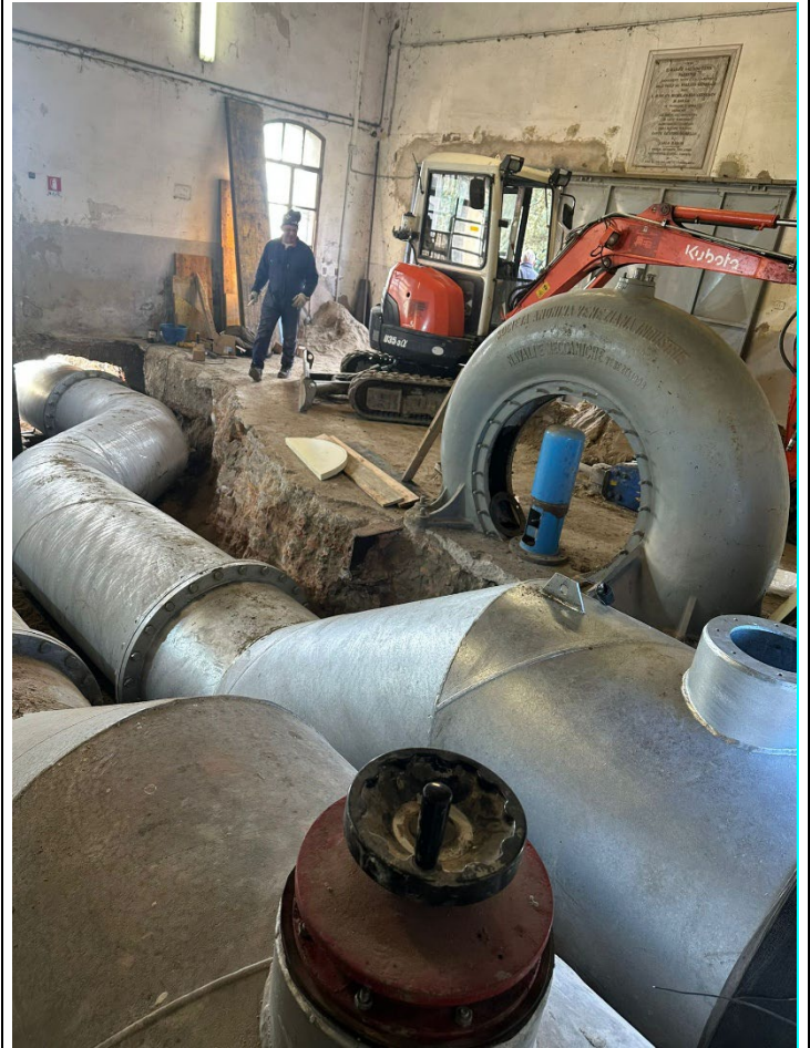
Idrovora Punta Gorzone - rifacimento tratto di condotta di scarico P2 in acciaio zincato.
