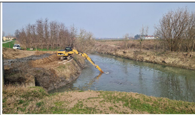
Scavo Immissione Derivazione Acquanera – Pernumia (PD)
