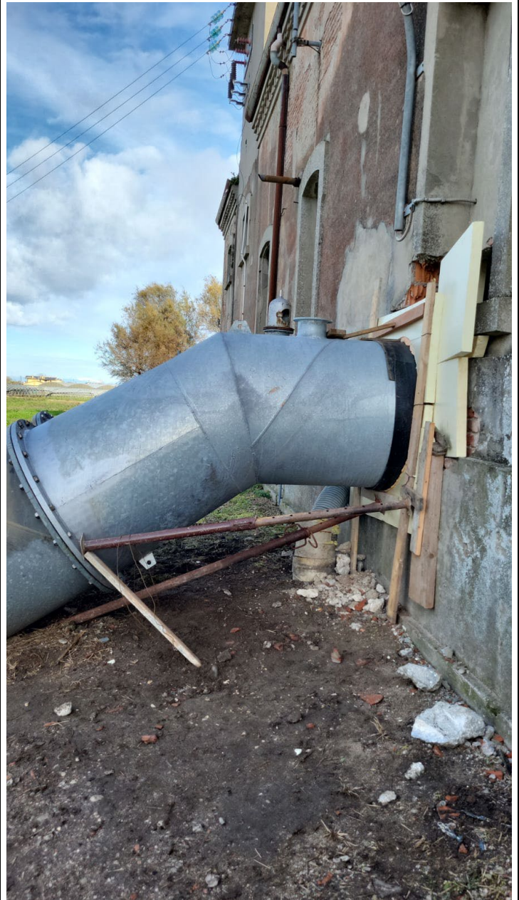
Idrovora Punta Gorzone - rifacimento tratto di condotta di scarico P2 in acciaio zincato.
