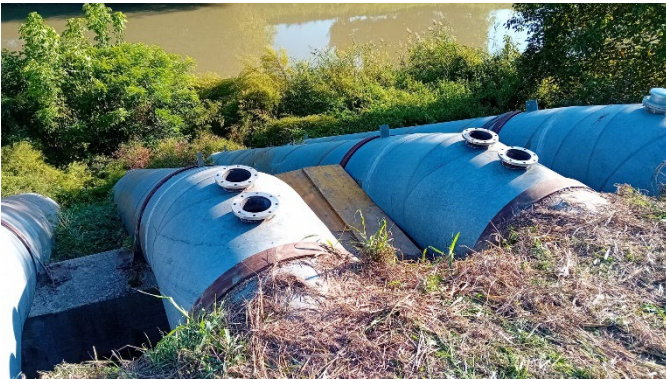
Idrovora Beolo - installazione valvole di sfiato sulle condotte si scarico pompe verticali per efficientare adescamento.
