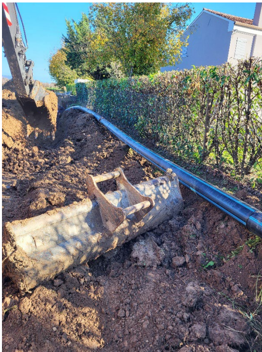
Sifone Giare - rifacimento tratto di condotta in PE.
