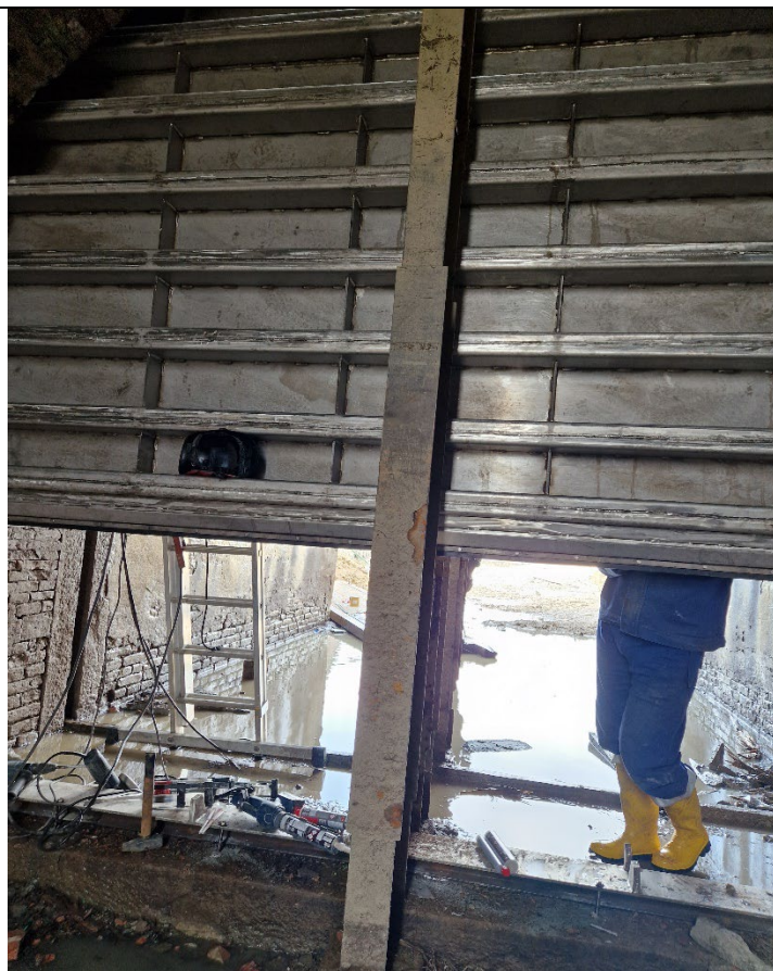
Idrovora Vampadore – assistenza per sostituzione paratoia antirigurgito dal Fiume Fratta – Megiadino San Vitale (PD)
