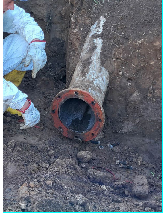
Sifone Giare - rifacimento tratto di condotta in PE.
