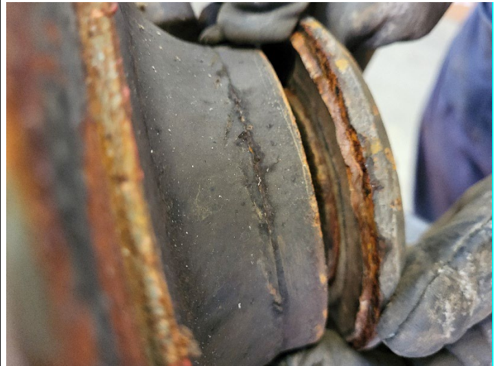
Idrovora Valgrande - revisione valvola di disadescamento.
