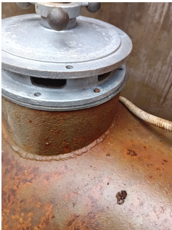
Idrovora Valgrande - revisione valvola di disadescamento.
