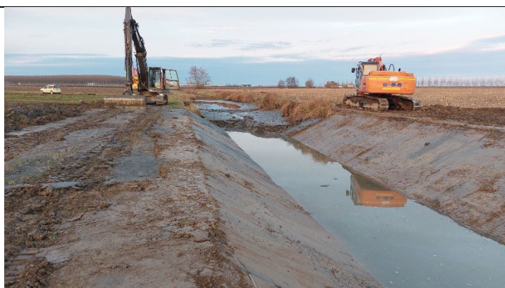
Scolo acque Alte Savellon – Consolidamento spondale con riporto di terreno – Monselice (PD)
