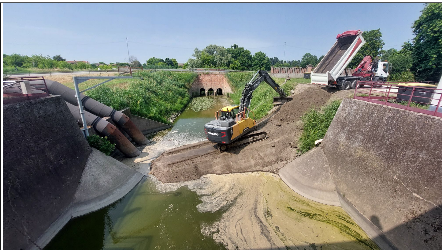
Idrovora Taglio – Esecuzione tura per sostituzione tubazione di scarico ammalorata della alicopompa – Anguillara Veneta (PD)
