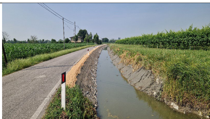
Scolo Primario Inferiore – Consolidamento spondale con riporto di terreno – Cavarzere (VE)
