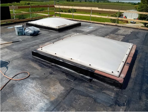
Idrovora Nuova Sabbadina – Lavori di rifacimento della guaina di copertura – Anguillara Veneta (PD).
