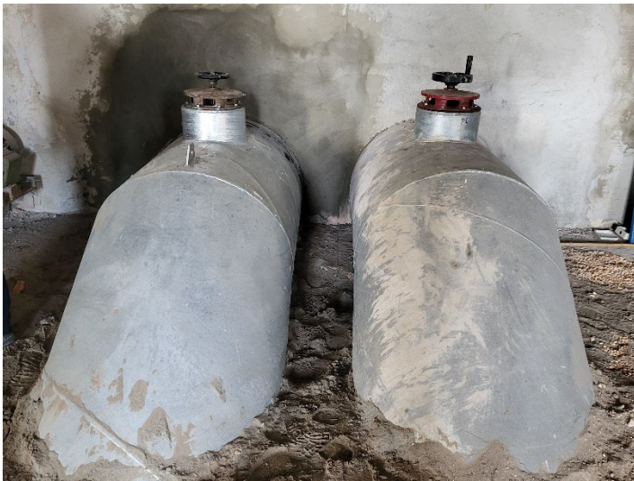
Idrovora Punta Gorzone - rifacimento tratto di condotta di scarico P2 in acciaio zincato.
