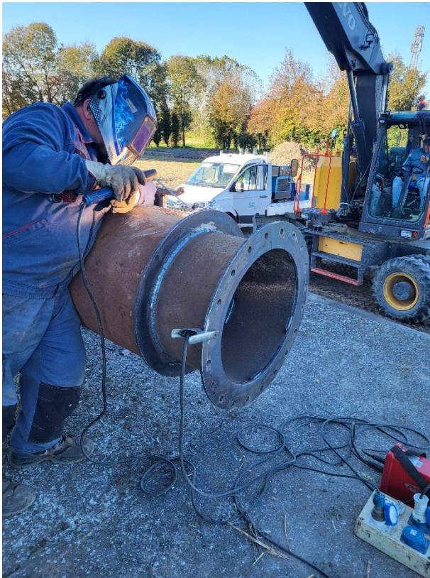
Idrovora Barbegara - installazione pompe di emergenza.
