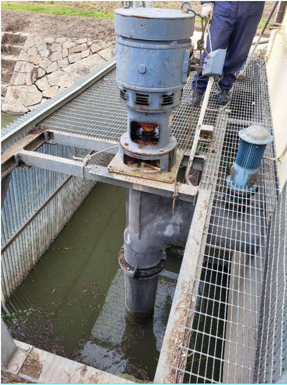
Idrovora Pelosa - lievo e revisione pompa verticale P1.
