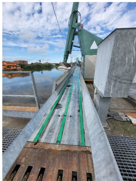
Sostegno Trezze - manutenzione straordinaria nastro sgrigliatore.
