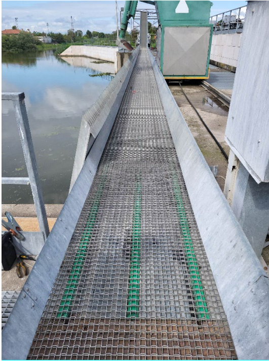
Sostegno Trezze - manutenzione straordinaria nastro sgrigliatore.
