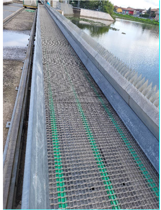
Sostegno Trezze - manutenzione straordinaria nastro sgrigliatore.
