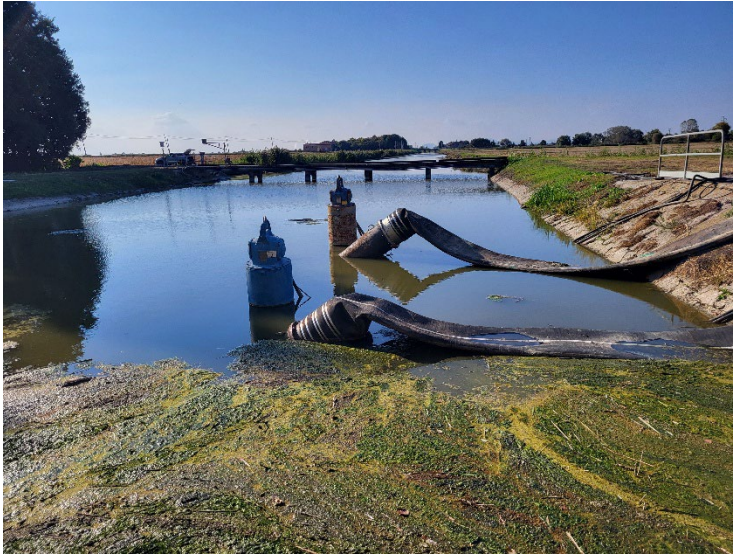
Idrovora Barbegara - installazione pompe di emergenza.
