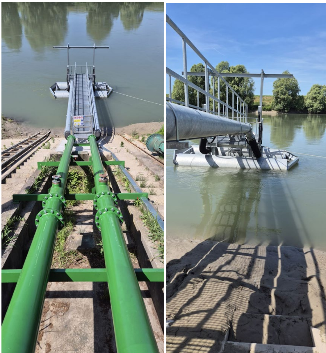
Nuova zattera per impianto di derivazione irrigua dal fiume Adige
