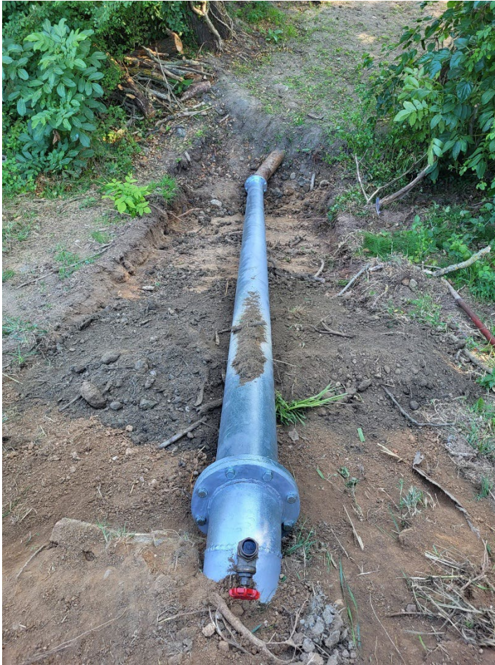
Sifoni Ex Macello - rifacimento tratto di condotta in acciaio zincato.
