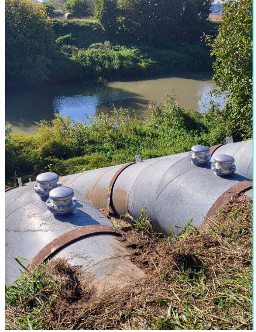
Idrovora Beolo - installazione valvole di sfiato sulle condotte si scarico pompe verticali.
