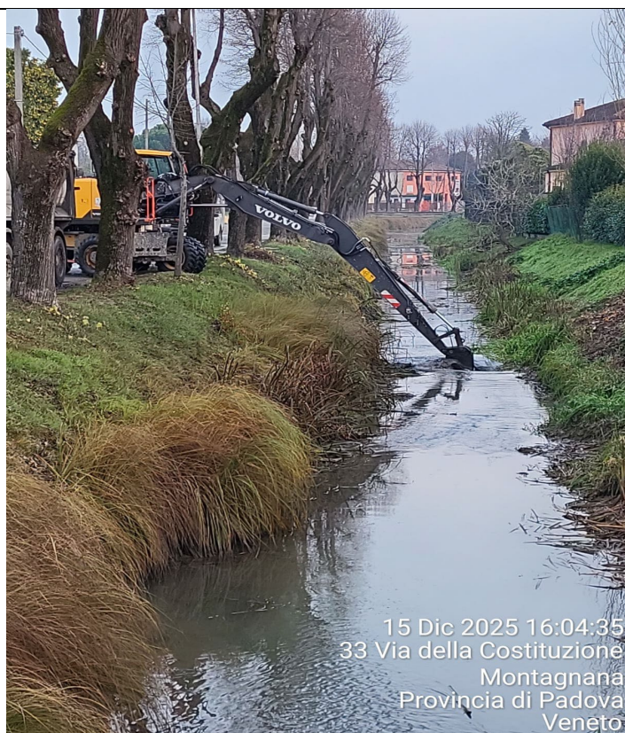
Scavo scolo Degora di Montagnana – Montagnana (PD)
