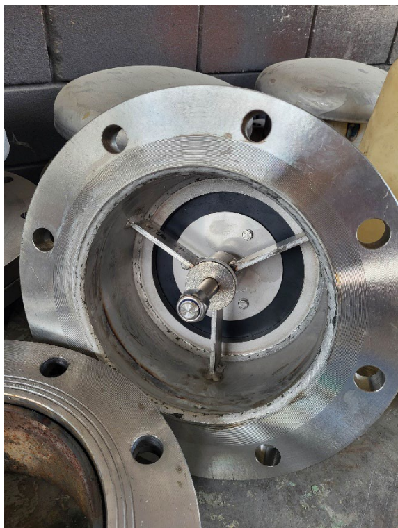
Idrovora Beolo - installazione valvole di sfiato sulle condotte si scarico pompe verticali.
