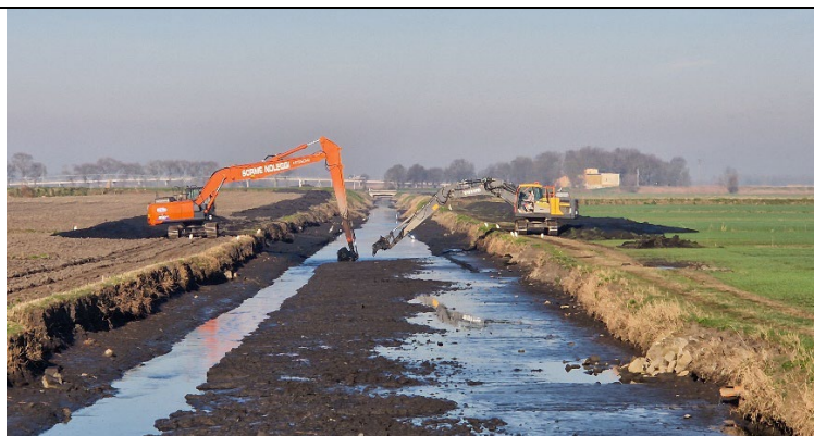
Scavo Scolo Primario Inferiore – Cavarzere (VE)
