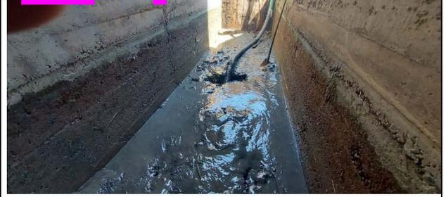
Briglia Guizza in aderenza al ponte stradale in Comune di Conselve. Pompaggio di cls. per sotto la platea per interdire una infiltrazione in asse del manufatto.
