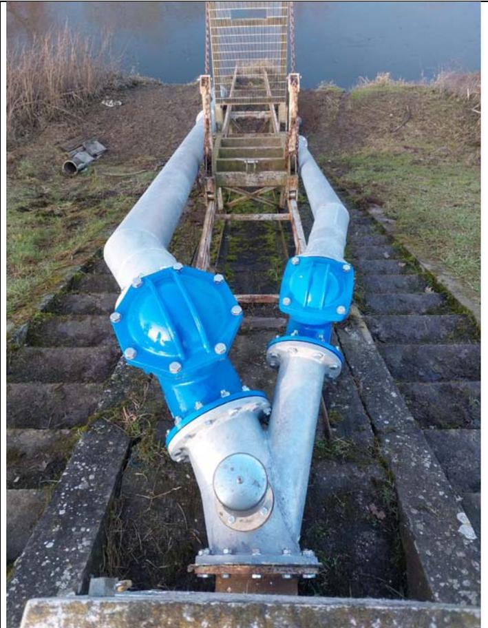
Rifacimento tubazioni di scarico complete di valvole di disadescamento Irriguo Mora Livelli 1
