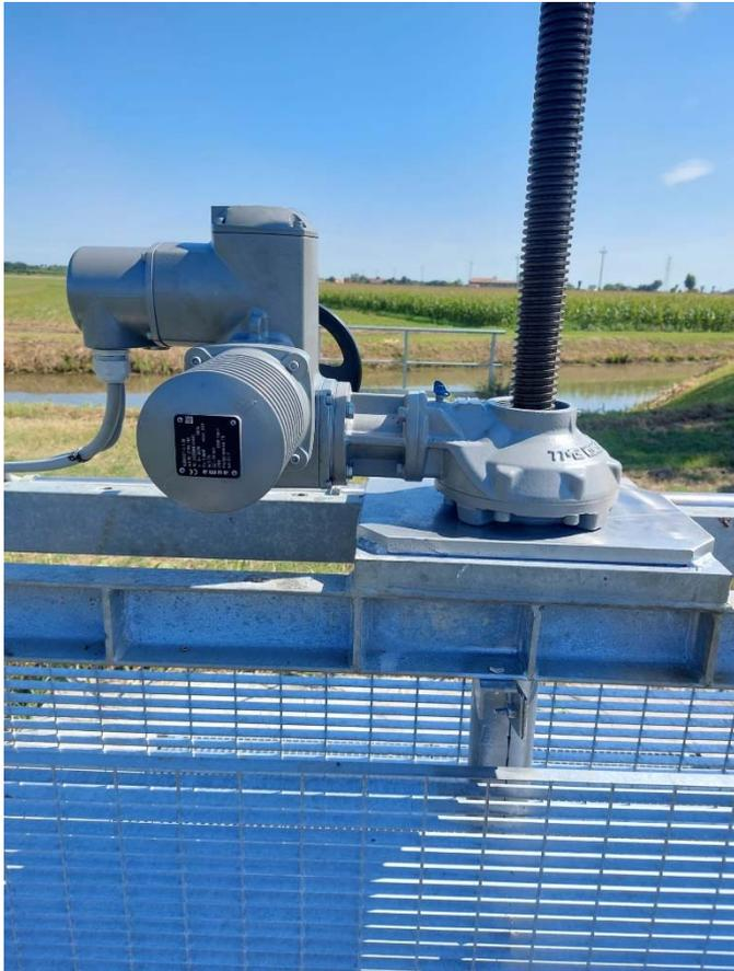
Sostituzione gruppo riduttore attuatore sostegno Gallo
