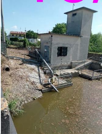
Sostegno Ponte Zata in Comune di Tribano. Posa di una pompa mobile per favorire l'alimentazione dello scolo Olmo durante la criticità idrica dovuta alla siccità.
