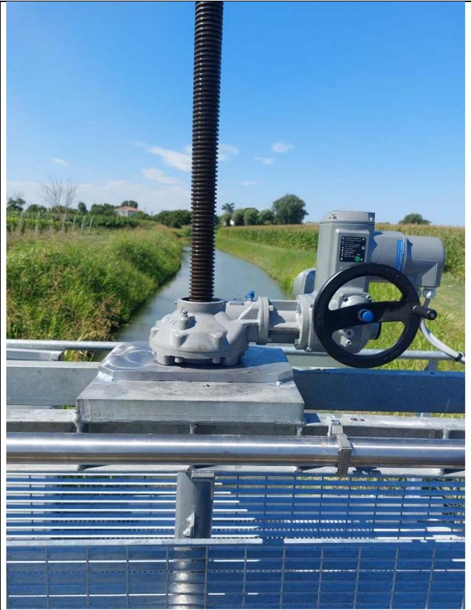
Sostituzione gruppo riduttore attuatore sostegno Gallo
