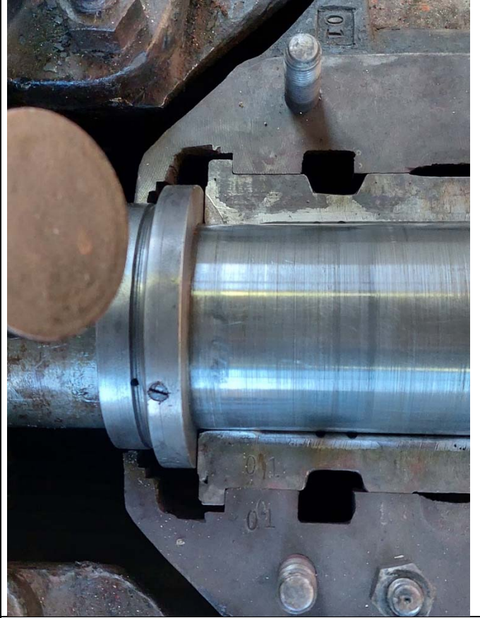
Ripristino bronzine in metal bianco idrovora Barbegara
