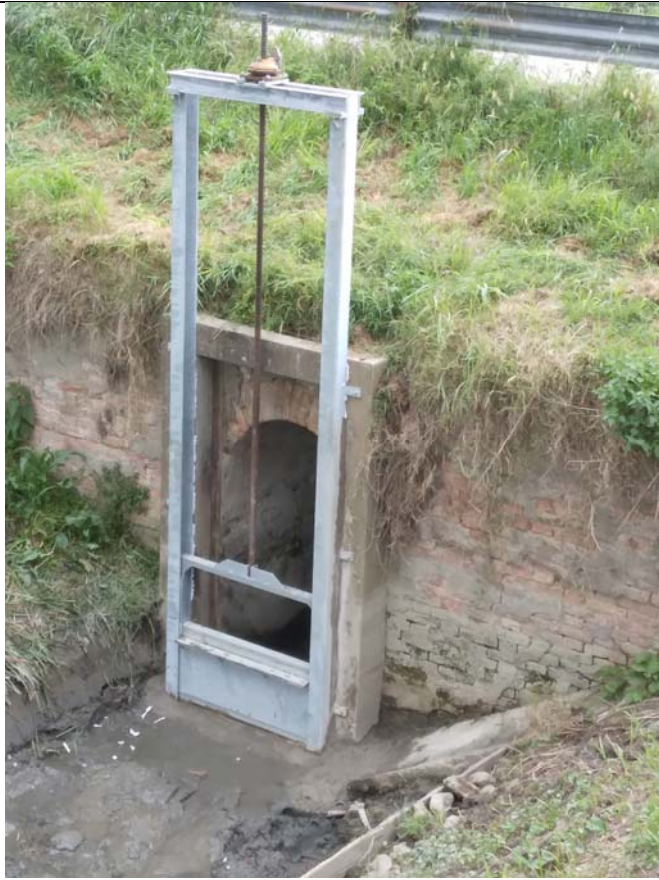
Costruzione sostegno Betto
