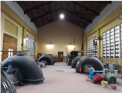
Idrovora Ca' Bianca di Chioggia – Lavori in D.A. di sistemazione interna degli intonaci e tinteggiatura
