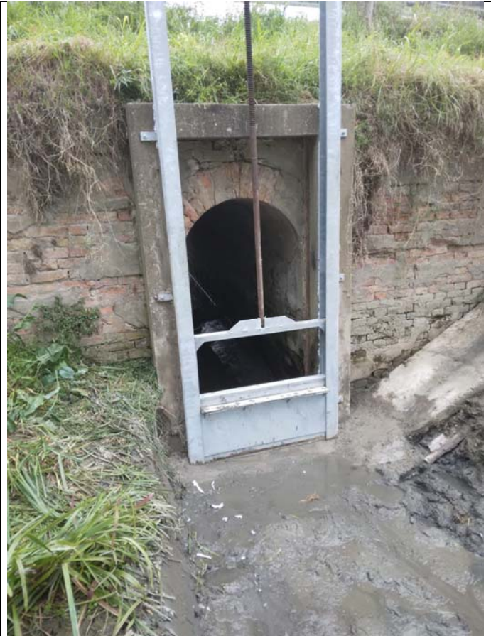
Costruzione sostegno Betto
