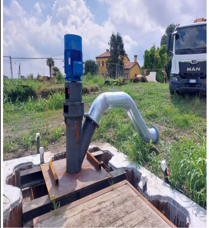
Posa di elicopompa e realizzazione condotta di scarico idrovora Cantarana
