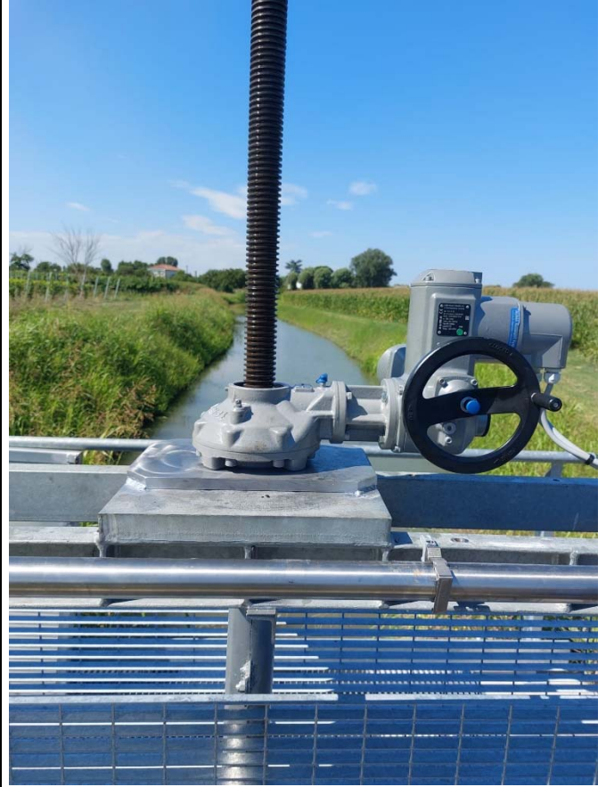
Sostituzione gruppo riduttore attuatore sostegno Gallo
