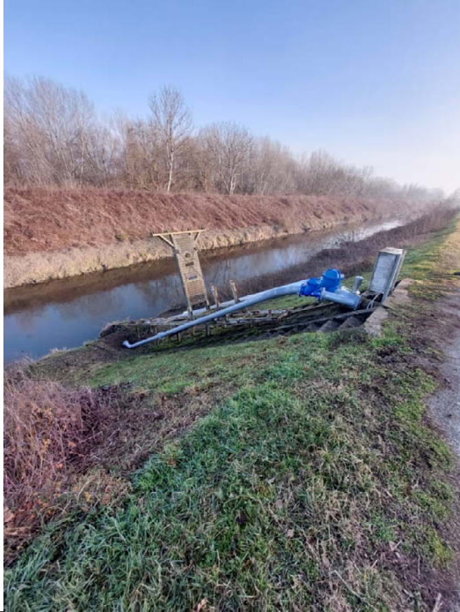
Rifacimento tubazioni di scarico complete di valvole di disadescamento Irriguo Mora Livelli
