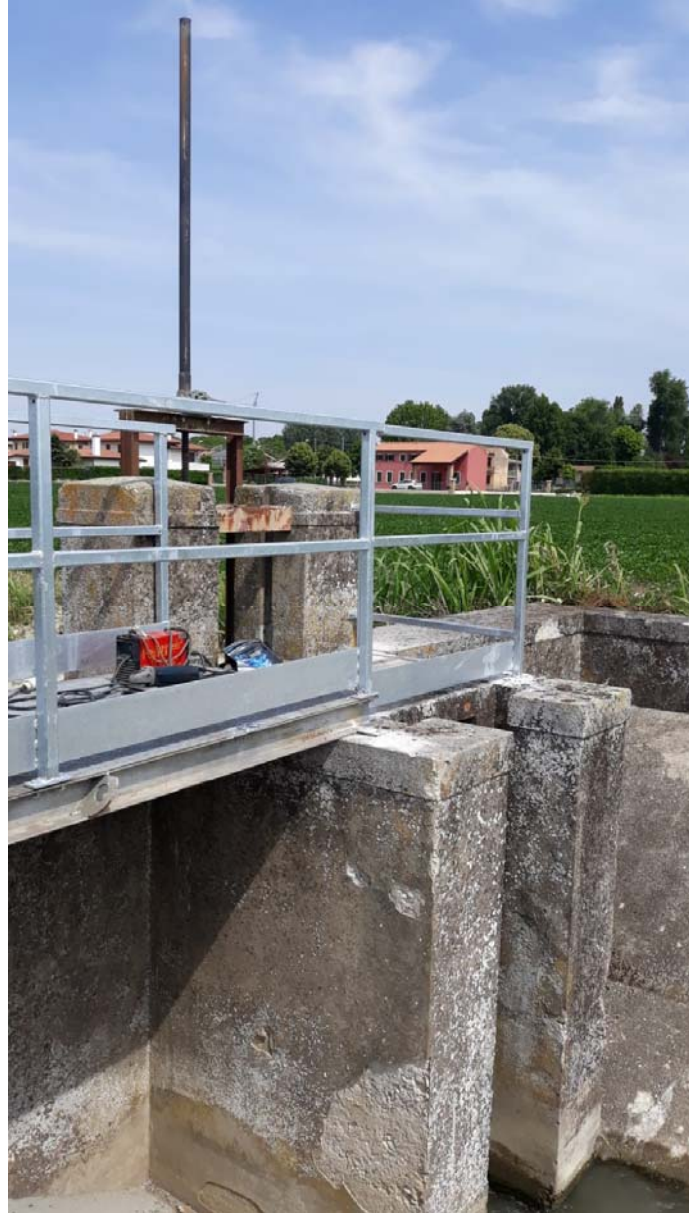
Realizzazione passerella Sostegno
