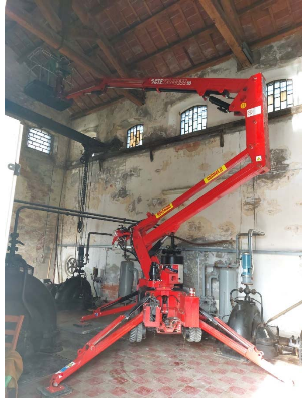
Sistemazione copertura idrovora Mora Livelli in comune di Vescovana (PD)
