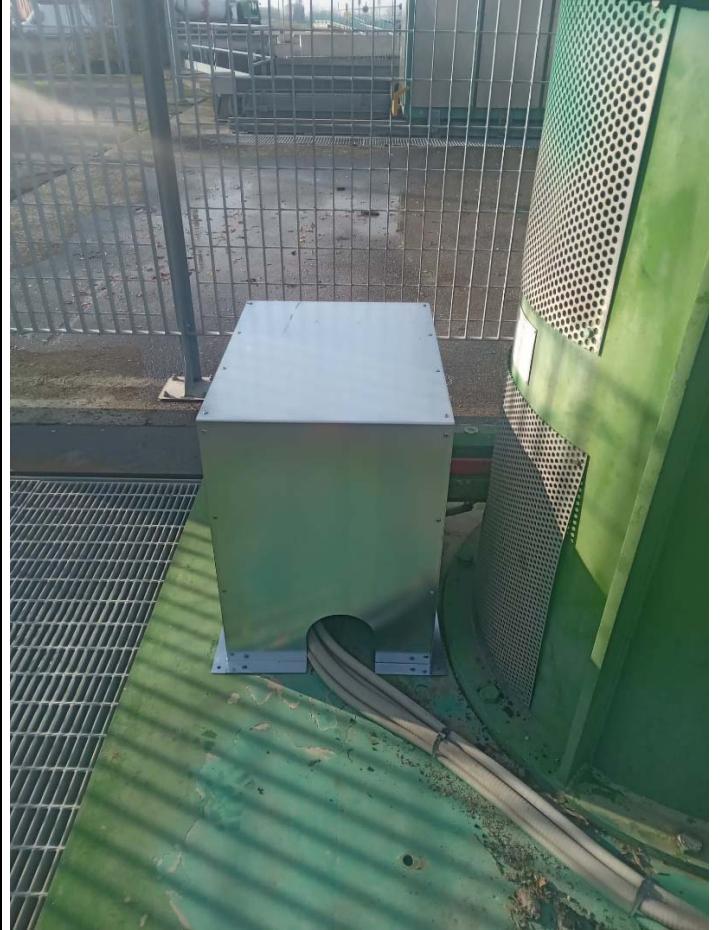
Manutenzione e copertura variapale idrovora Trezze
