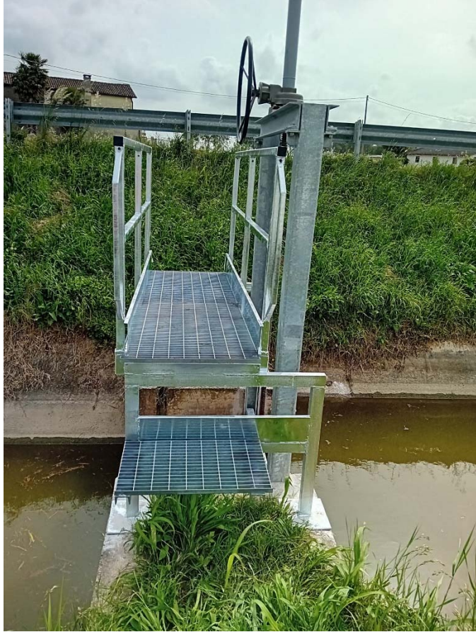
Costruzione sostegno Zulian
