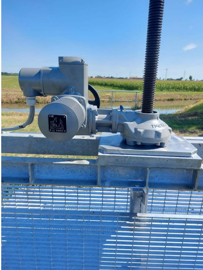
Sostituzione gruppo riduttore attuatore sostegno Gallo
