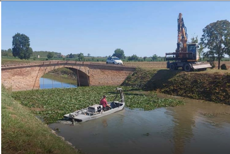
Canale Altipiano in Comune di Correzzola. Attività di sfalcio con motobarca diserbatrice.
