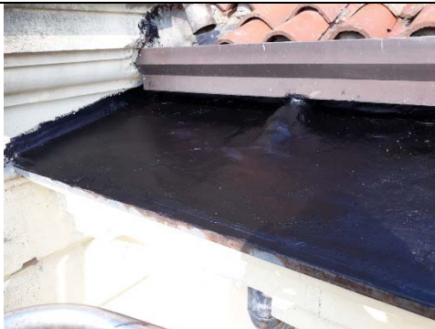
Idrovora Rebosola di Pegolotte di Correzzola. Sistemazione dei cornicioni deteriorati dell'impianto idrovoro
