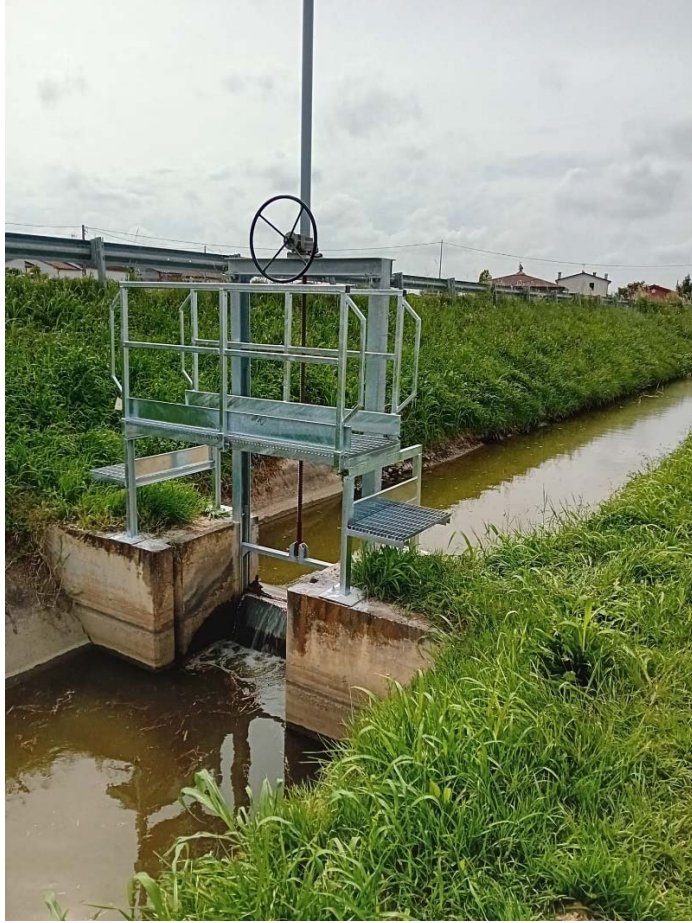
Costruzione sostegno Zulian
