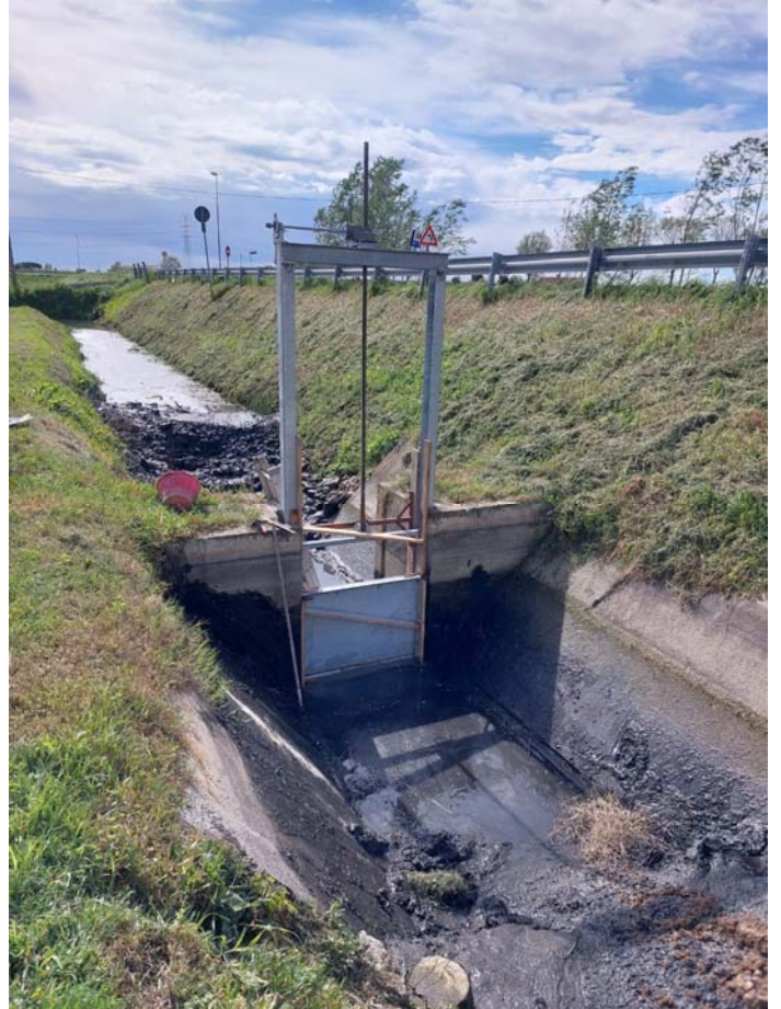
Costruzione sostegno Zulian
