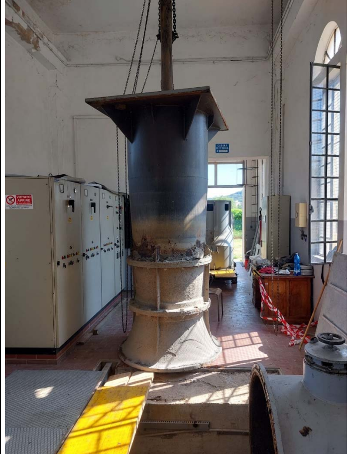
Manutenzione straordinaria pompa n° 3 idrovora Ca' Bianca di Galzignano
