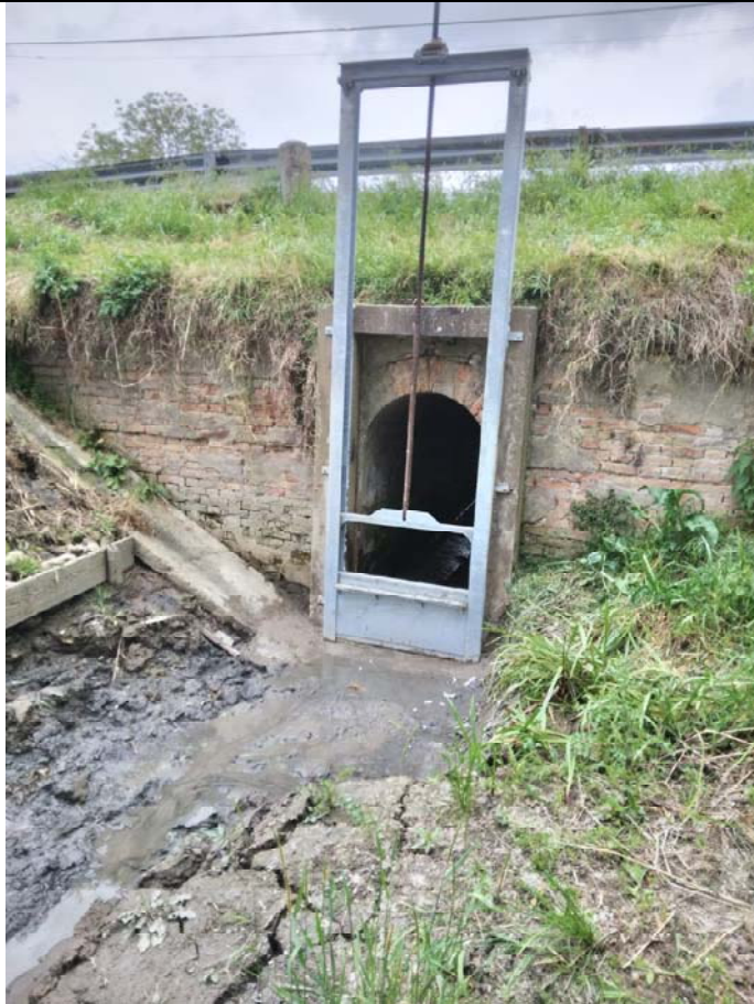
Costruzione sostegno Betto
