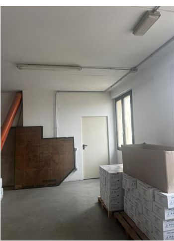
porta REI che conduce ai locali del Consorzio Bonifica Adige Euganeo.
