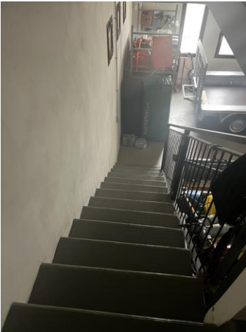
scale uscita dal piano primo a piano terra
